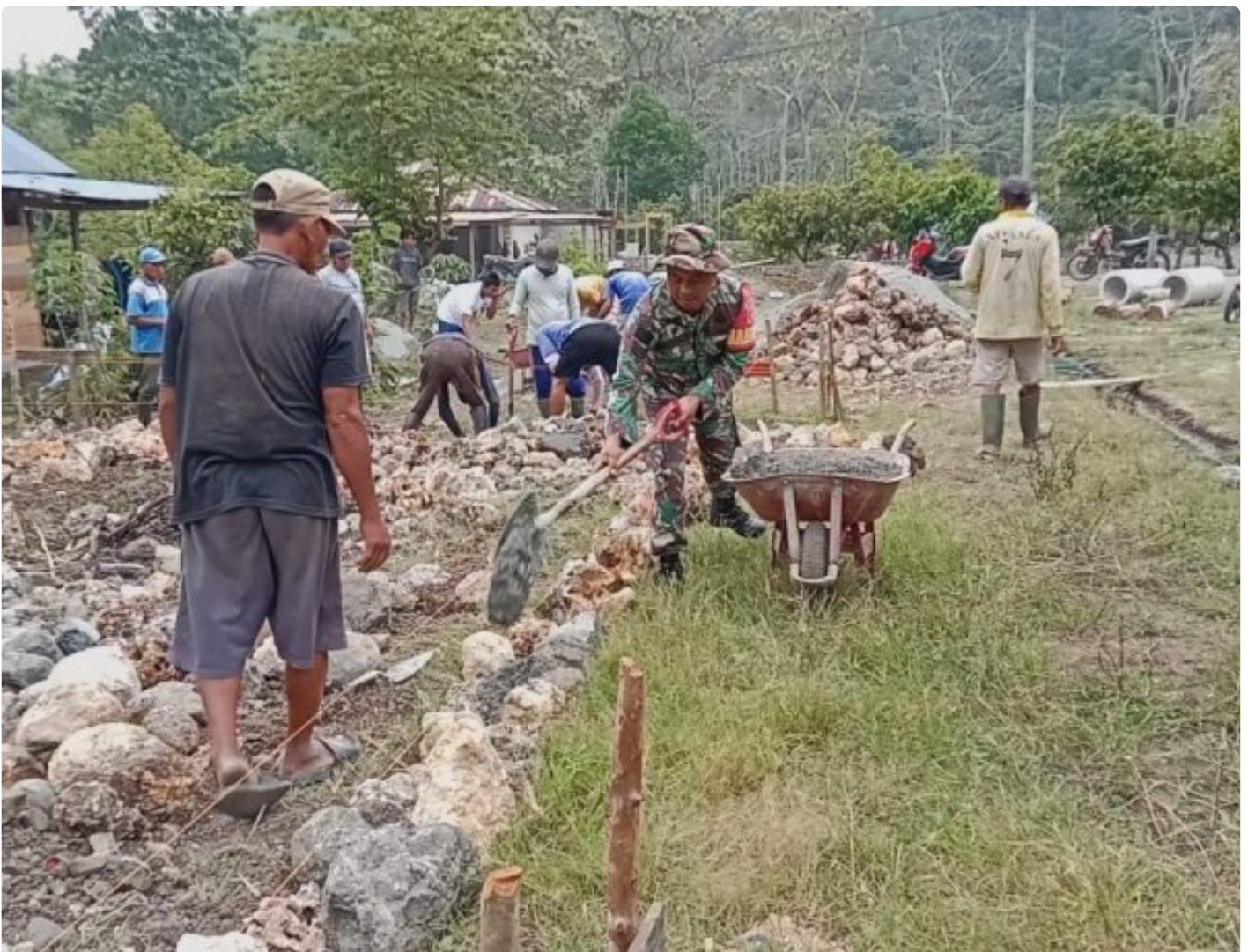
Gotong royong bangun pondasi rumah warga
